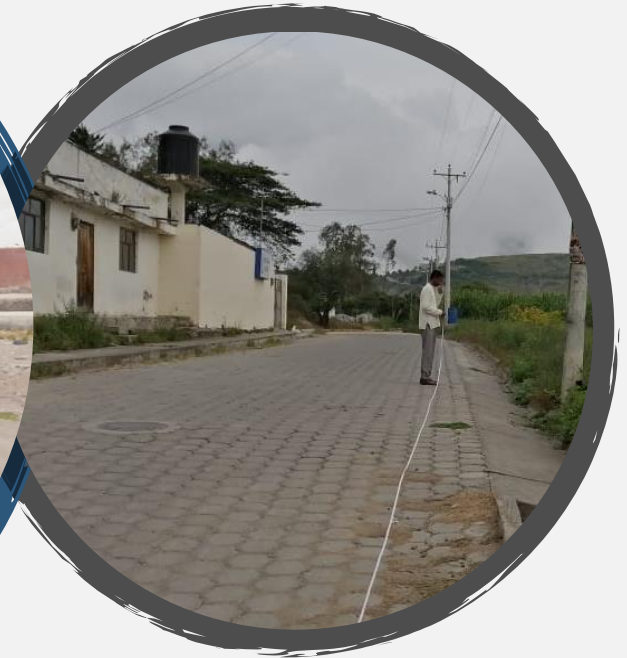
ACERAS BARRIO SAN MARTIN
